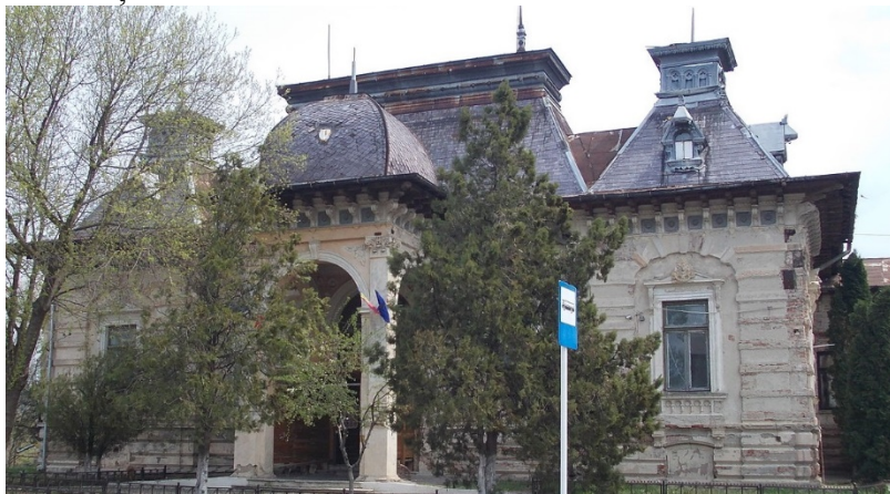
Casa Mavrocordat (sau Palatul Copiilor). Clădirea a fost construită între anii 1883 și 1892 de către Gheorghe Mavrocordat.
